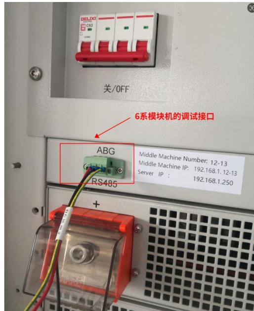
图 5. 接线位置实物参考图
